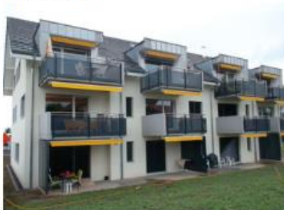
Chemin de l'Ancien Tram 2,4,6,8,10
