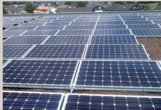
Photovoltaikanlage auf dem Dach des Neubaus in Therwil (Modulfläche von 380 m<sup>2</sup> und einer Spitzenleistung von 59 kWp).
