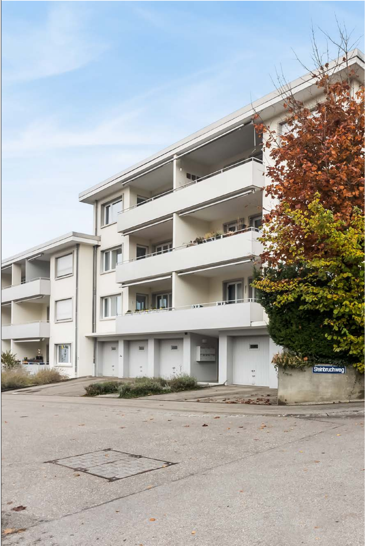
Liegenschaft Olten SO 12 Wohnungen 1961 (2019 totalsaniert)
