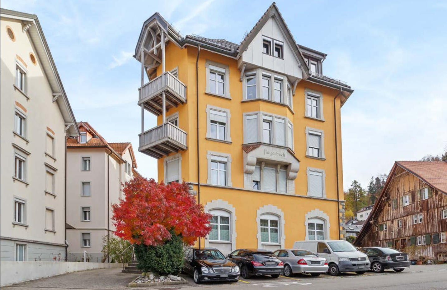
Liegenschaft St. Gallen SG, 18 Wohnungen, Baujahr 1920 (1979, 2015 - 2020 totalsaniert)
