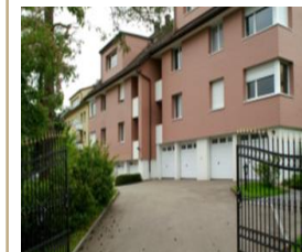
Zollikerberg 10 Wohnungen Sanierung 2014 Verkehrswert 7.07 Mio.
